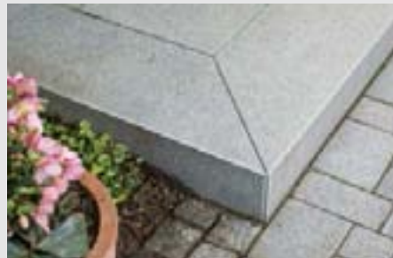
Gehrungsschnitte bei Blockstufen – ob Naturstein oder Keramik-Verbund-Produkte ...
