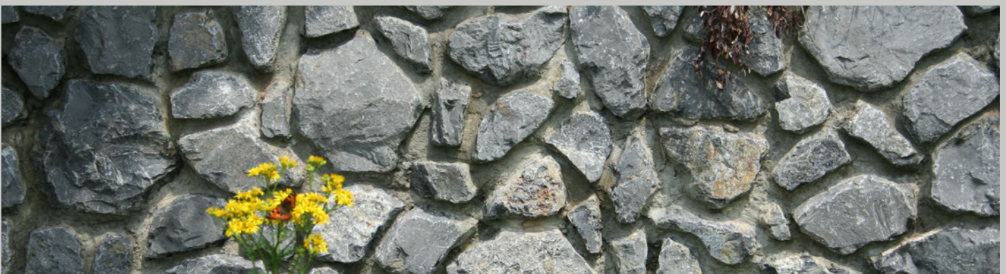
Fest vermörtelte Mauer aus Kalkstein
